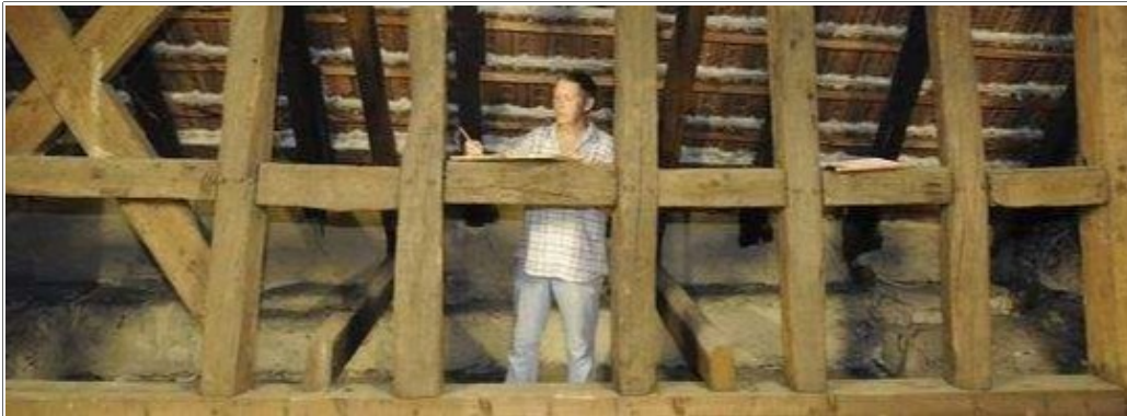
Es riecht ekelig nach Schwefel und faulen Eiern aus dem etwa 1x1 Meter großen und ungefähr 1,20 Meter tiefen Loch im Fundament von Schloss Strünkede.
